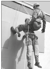
Példa: Evakuálás a Milan leeresztőeszközzel.
